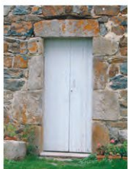
Borée, porte avec linteau droit et arc de décharge
