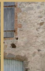
Enduit de jointoiement.
