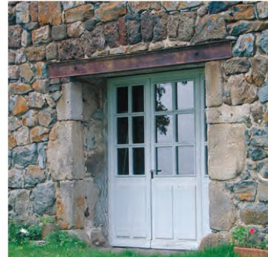
Borée, ouverture agrandie avec un linteau métallique droit qui permet la pose aisée d'une menuiserie vitrée. L'ancien cintre sert d'arc de décharge.
