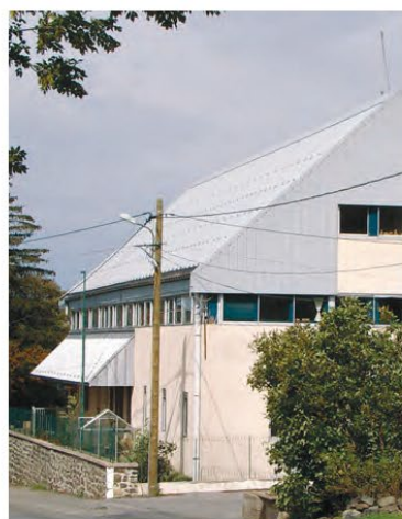
Le Béage. Forme de toiture traditionnelle en tôle avec ouvertures en bandeau allégeant le volume général.
