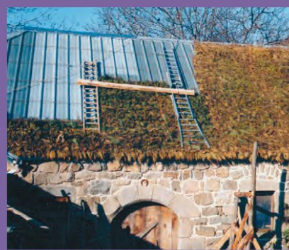
Borée, rénovation d'une toiture en genêts
