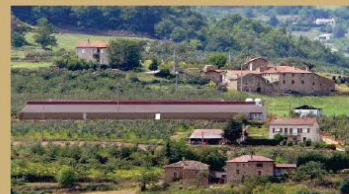
Simulation de colorisation en brun foncé pour atténuer l'impact visuel. Il est important de traiter murs et toitures de la même couleur. Des plantations supplémentaires peuvent contribuer à mieux le masquer.
