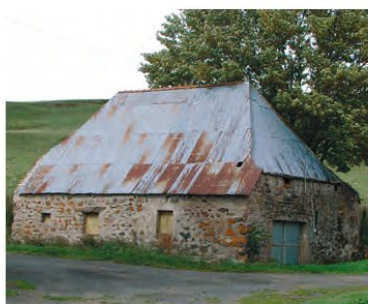
Le Béage, toiture en tôle
