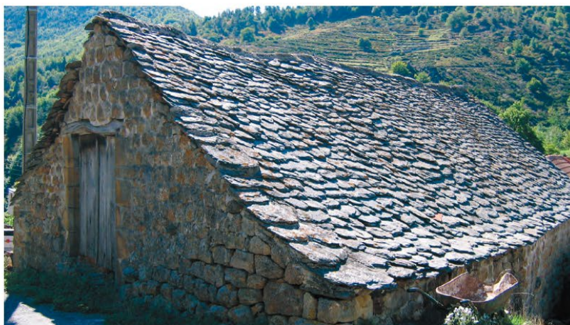
Le Chambon, toiture ancienne de lauzes
