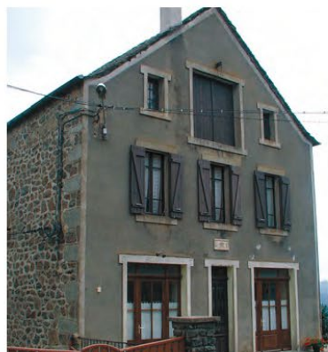
Borée, façade pignon couverte d'un enduit laissant apparaître les encadrements de fenêtres en saillie. Ces décorations donnent une certaine noblesse à la façade principale. La façade latérale, moins visible depuis la rue reste en pierre apparente avec joints bien couvrants à la chaux.
