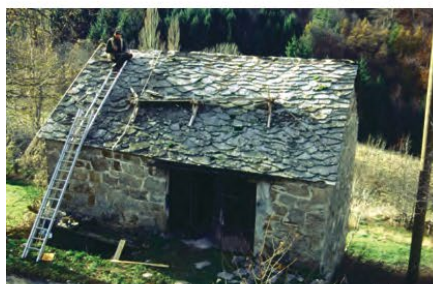
Réparation d'une toiture de lauzes
