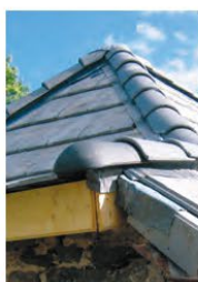
Réhabilitation de la toiture en tuiles ciment noires (aspect lauze discutable)
