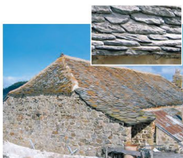
Borée, toiture de lauzes
