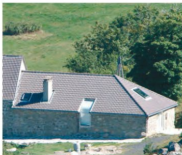
Saint-Martial, ouvertures créées en combles
