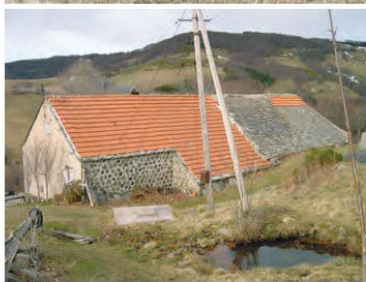
L'habitat vernaculaire est souvent implanté dans un repli naturel du terrain afin d'offrir le minimum de surface aux intempéries et aux vents dominants.
