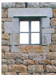
Le Béage, Petite fenêtre en pierres taillées et linteau droit
