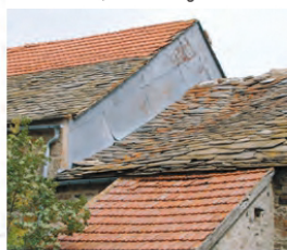
Le Béage, lauzes et tuiles en terre cuite
