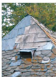
Réparation de la toiture de lauzes à l'aide de tôle ondulée
