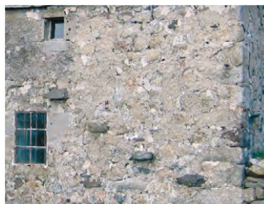
Exemple d'enduit de jointoiement dit "enduit à pierre vue" ou "enduit à tête vue".
