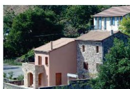
Extension d'une maison ancienne. L'enduit est trop clair donc trop visible.
