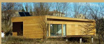
Maison à ossature et bardage bois.
