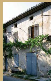
Ancien enduit à la chaux.
