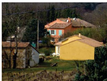
Deux maisons récentes aux teintes vives, à côté d'un petit bâtiment en pierre de pays. L'impact visuel est flagrant et dénature l'harmonie d'ensemble du site.
