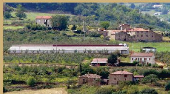
Grand bâtiment agricole dans un environnement bâti de qualité. Ses matériaux sont manufacturés et sa teinte est trop claire. Son impact visuel est impressionnant et rompt l'harmonie du site.
