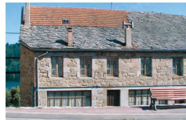
Saint-Martial, agrandissement d'ouvertures avec un linteau métallique. Paradoxalement, ce type de linteau est cohérent dans l'organisation de la façade.
